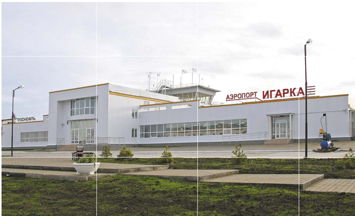
Новое здание аэропорта, построенное НК «Роснефть» в г. Игарка
