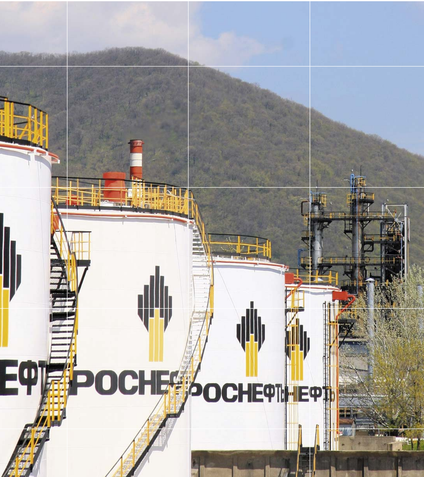
Резервуарный парк Туапсинского НПЗ
