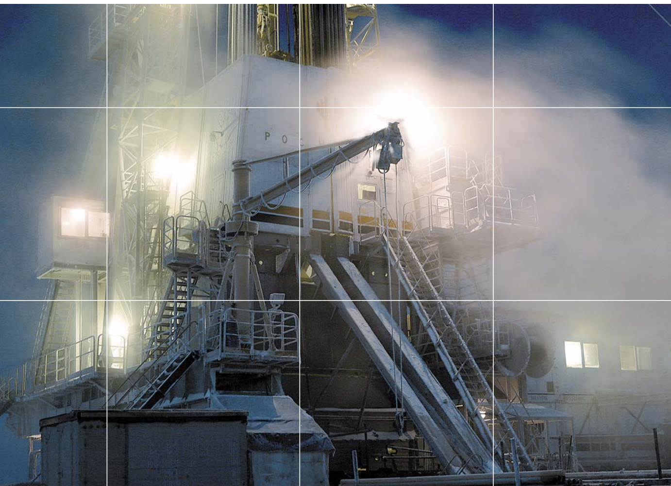
Буровые работы на Ванкорском месторождении
