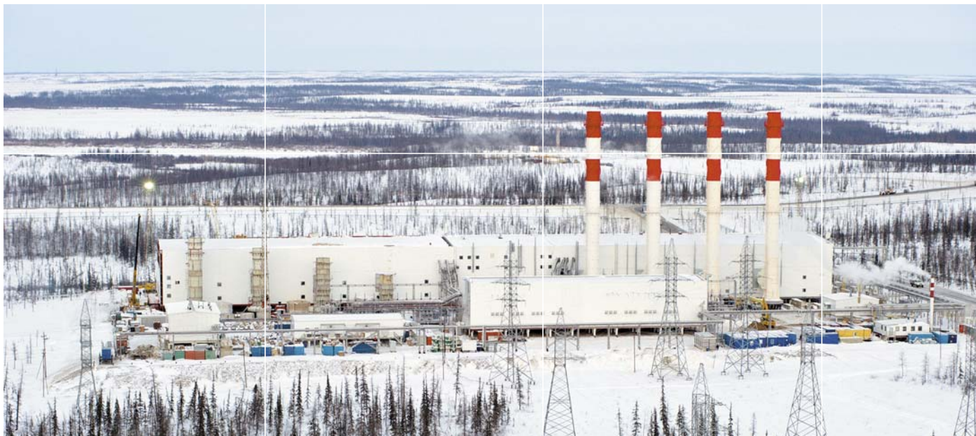
Газотурбинная электростанция на Ванкорском месторождении
