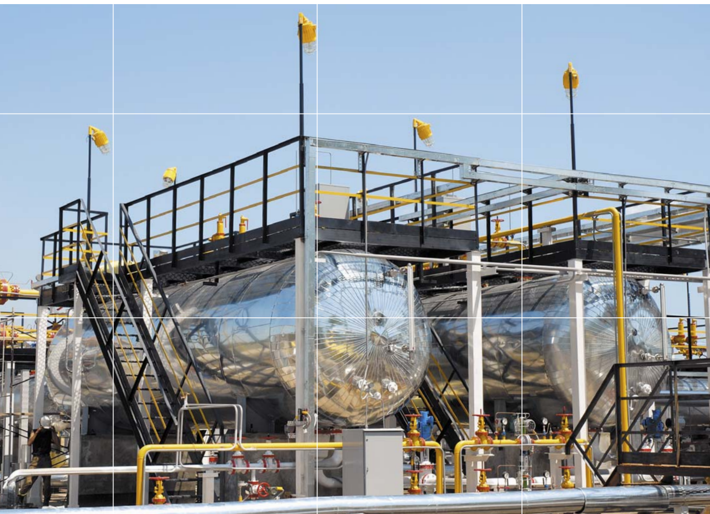
Сепаратор газонефтяной групповой установки № 58 ООО «РН-Краснодарнефтегаз»
